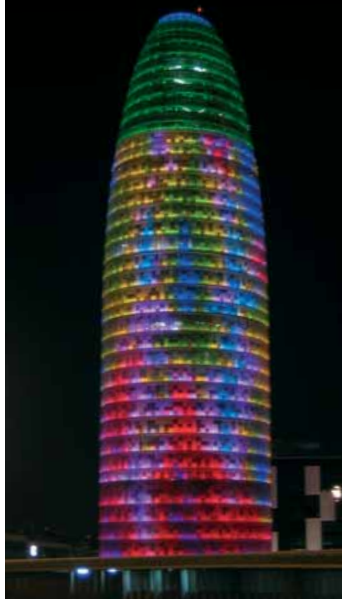
La Torre Agbar, il·luminada de nit, obra de Jean Nouvel (2005)
